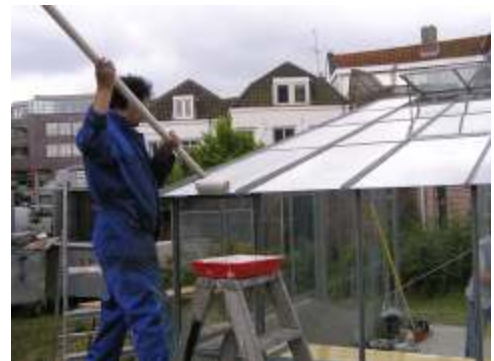
Het aanbrengen van "Temperzon"
