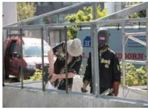
Lassen en afwerken
