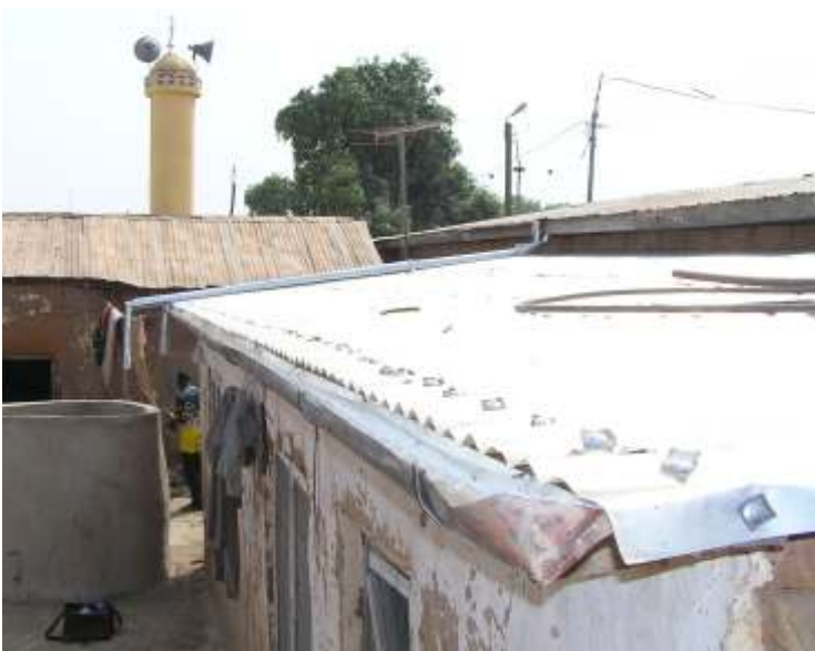
Het "Water harvest system" met goot en riet-cement tank.
